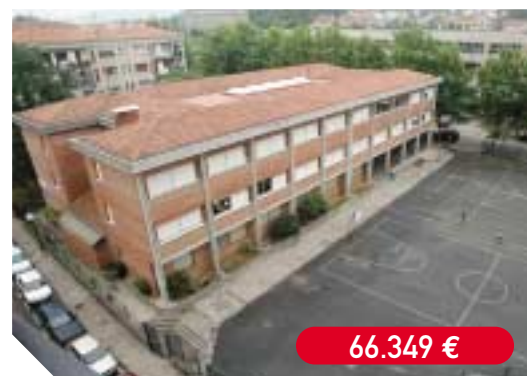
Reparación de la cubierta del colegio Belaskoenea
