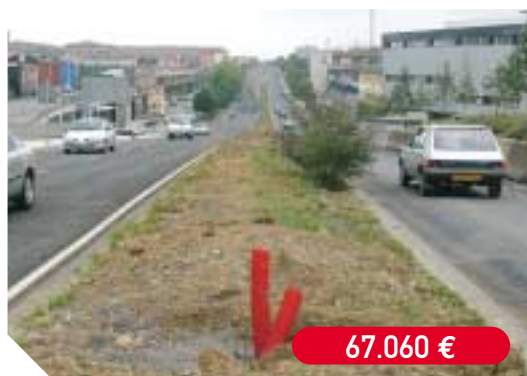
Colocación de farolas en la avenida de Letxunborro
