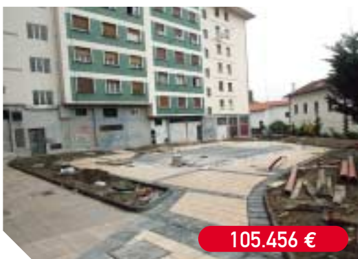
Remodelación de la trasera de la calle Eguzkitza
