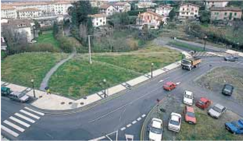
Glorieta de conexión Euskal Herria, Gipuzkoa y Elizatxo 200 millones
