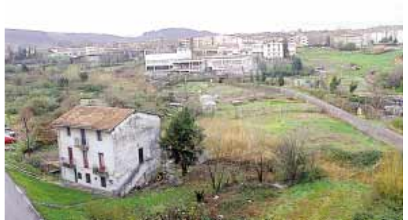
Parcelas de San Miguell/Anaka, donde se construirán 800 viviendas de protección oficial
