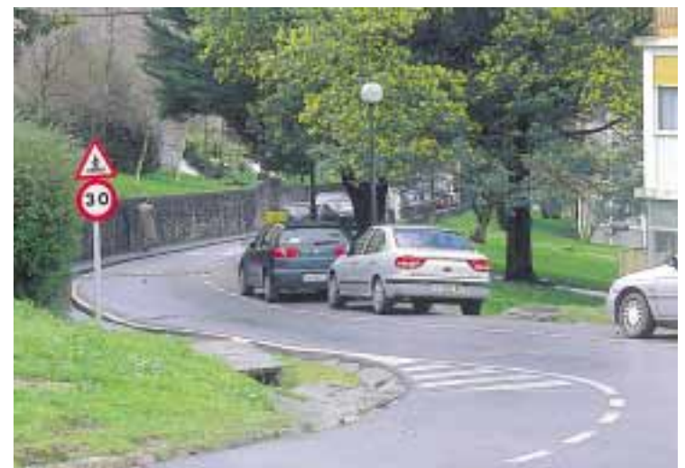
Reurbanización de un tramo de la calle César Figuerido y un aparcamiento 116 millones
