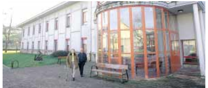
Reformas en la residencia municipal de ancianos 34 millones
