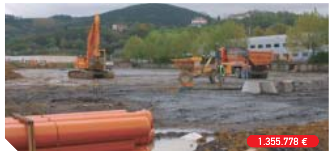
Instalaciones deportivas de Ugalde-Ventas
