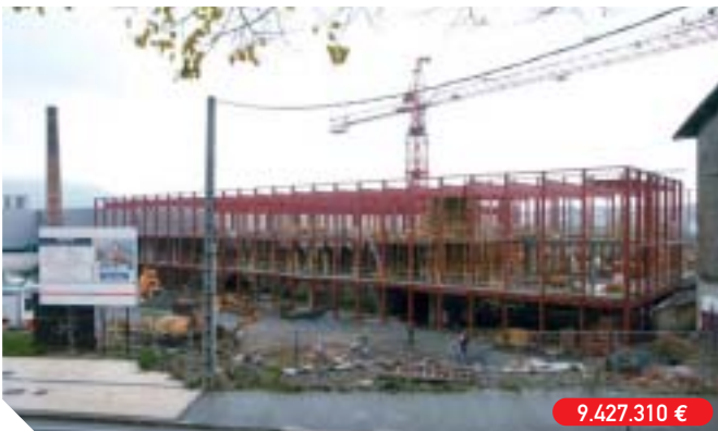
Ejecución 1ª fase de las instalaciones deportivas de Azken Portu
