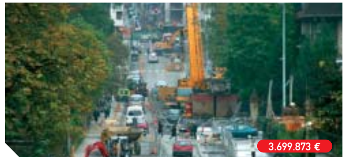
Urbanización y colector Avda. Iparralde
