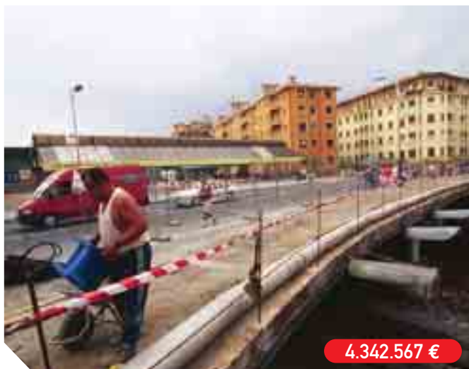
Construcción de una barandilla en el puente del ferrocarril (remate de las obras del paseo de Colón)
