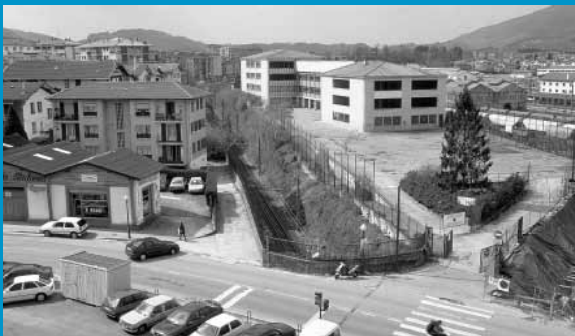
Nuevo depósito de vehículos en la calle Aduana En el solar ocupado anteriormente por el colegio Jaizkibel.
